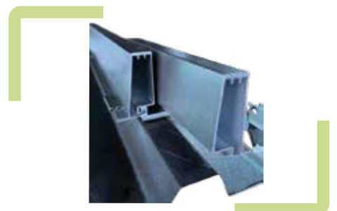
Fixation des rails par S-CLIP
